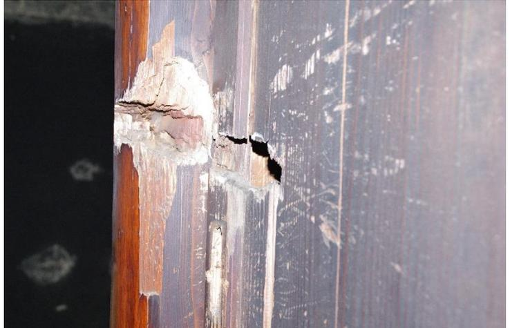
の「床の間」より南から入ってきて、床柱の右側を削りながら2段戸棚の上段引戸を貫通している。床柱を通り抜ける際に飛び散った木片が引戸の表面をこすった創がついている。相当の勢いがあったと想像できる。
